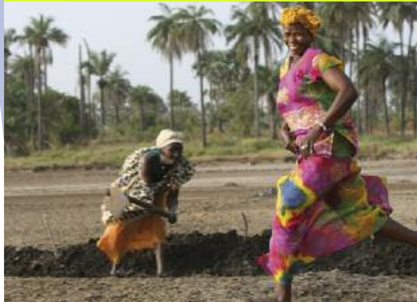
Beim Deichbau in der Casamance
